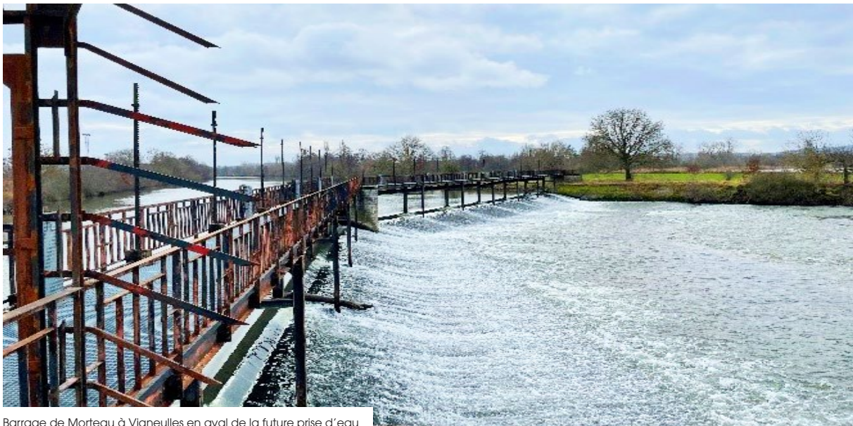
Barrage de Morteau à Vigneulles en aval de la future prise d'eau
