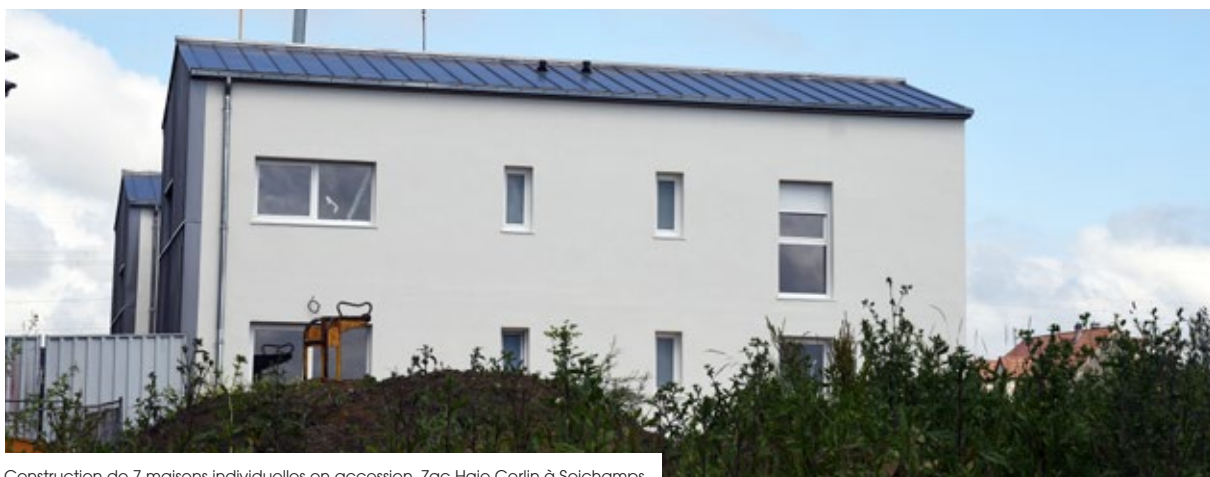
Construction de 7 maisons individuelles en accession, Zac Haie Cerlin à Seichamps
