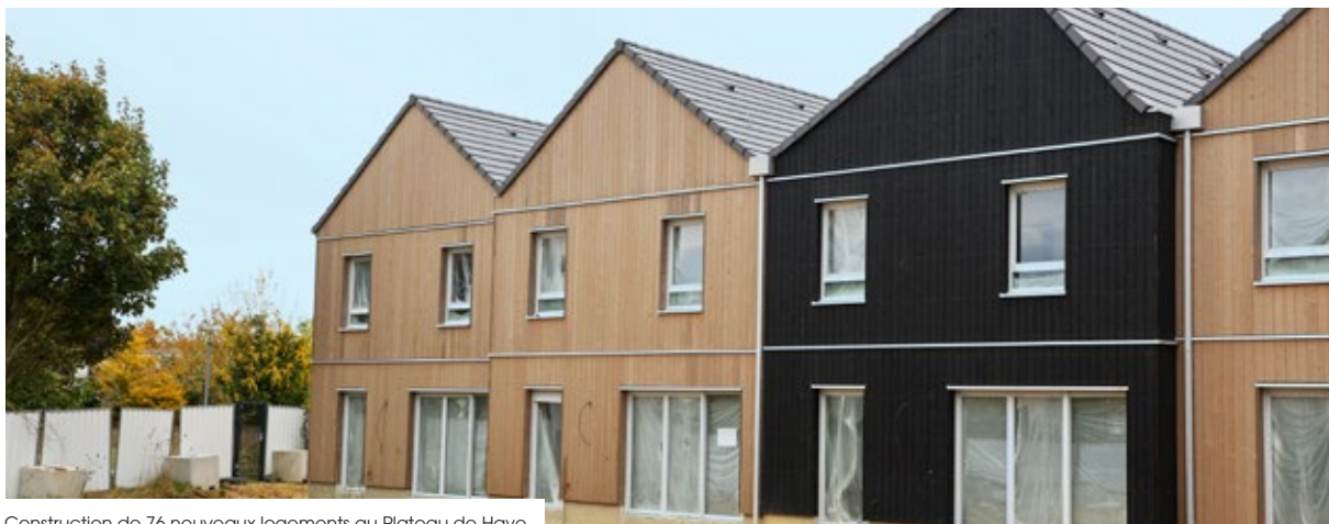
Construction de 76 nouveaux logements au Plateau de Haye
